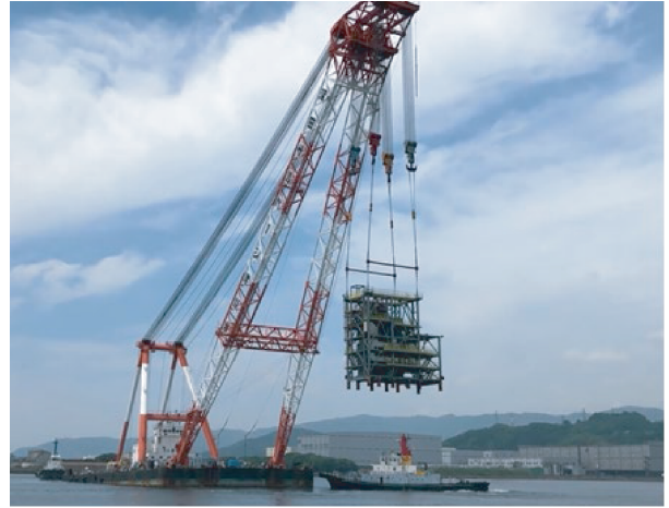
写真2 ボイラの海上クレーン吊り上げ状況写真 Photo 2 Lifting boiler by marine crane
